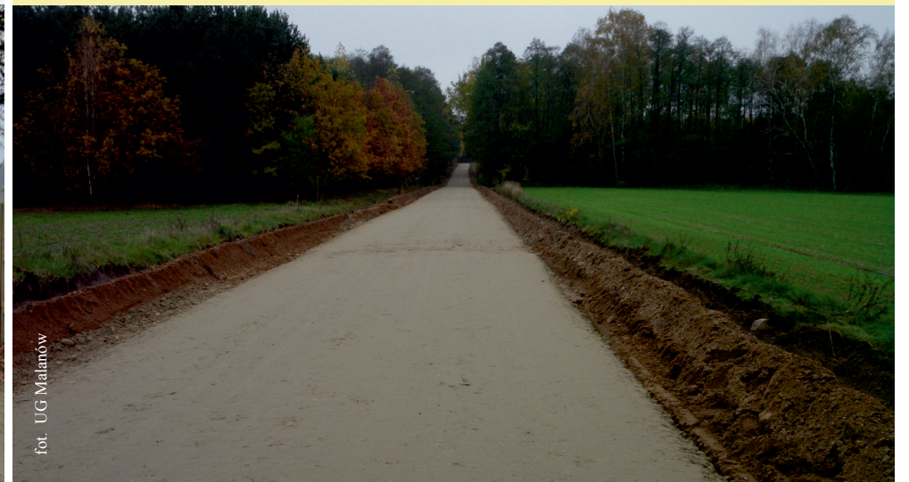
Droga Kotwasice-Zygmuntówek w czasie przebudowy
