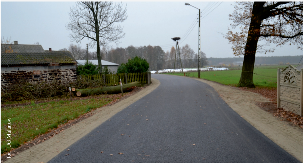
Nowa nawierzchnia drogi w Bibiannie
